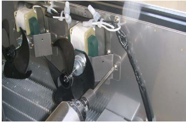
B.Remove the evaporator fan motor
